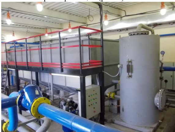
Рисунок 1 – Установка напорной флотации
