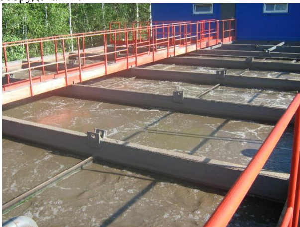
Рисунок 2 – Установка биологической очистки
